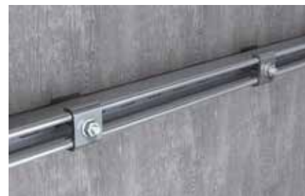
Installazione binario di montaggio a muro
