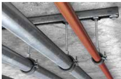
Fissaggi di tubazioni su canale a soffitto
