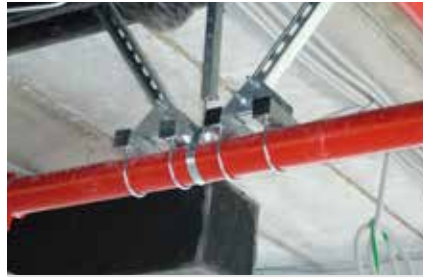
Costruzione di controventi
