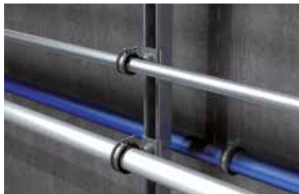
Installazione laterale tubazioni su binario di montaggio
