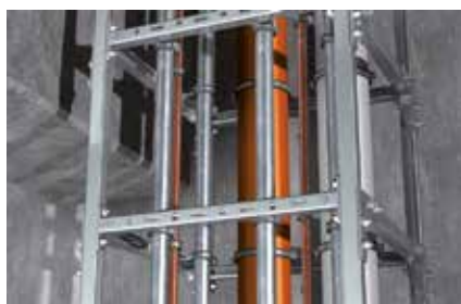
Strutture a telaio 3D
