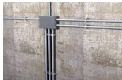
Fissaggio tubi in PVC
