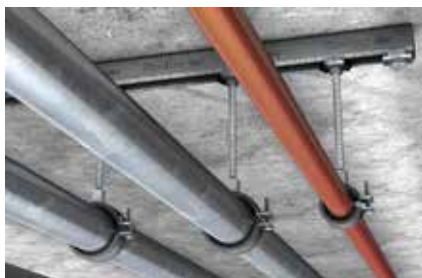
Installazione di tubazioni sui profili FLS
