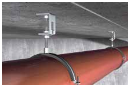
Installazione di tubazioni regolabili in altezza
