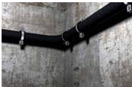
Fissaggio delle condotte in plastica
