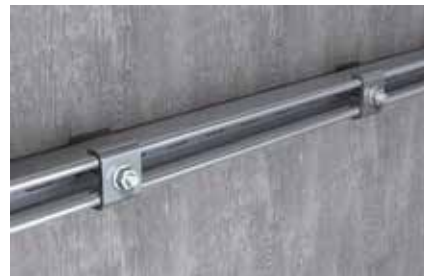
Installazione binario di montaggio a muro
