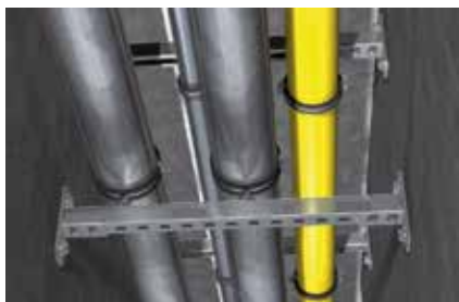
Installazione tubazioni su via di fuga
