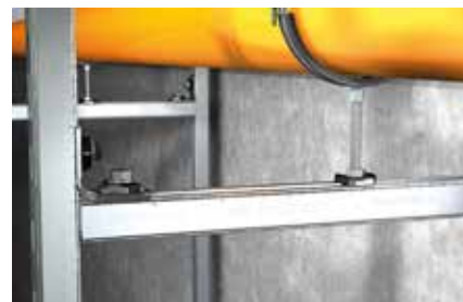
Installazione di tubazioni su telaio
