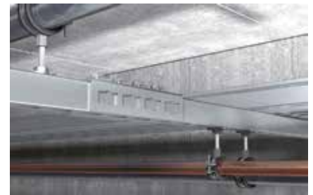
Connessione longitudinale binari di montaggio
