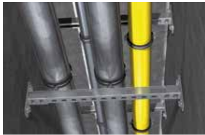
Installazione tubazioni su via di fuga
