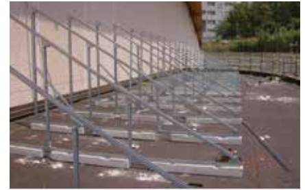
Costruzione di telai per pannelli
