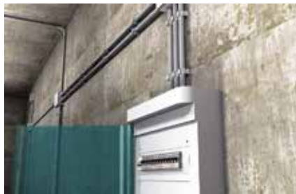
Fissaggio tubi in PVC
