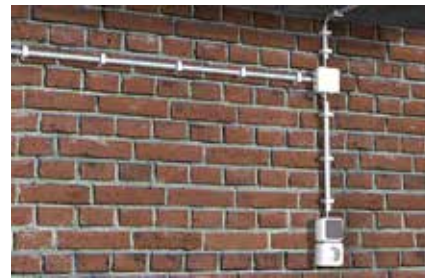
Fissaggio di fasci di tubi
