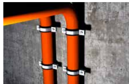
Fissaggio delle condotte in plastica
