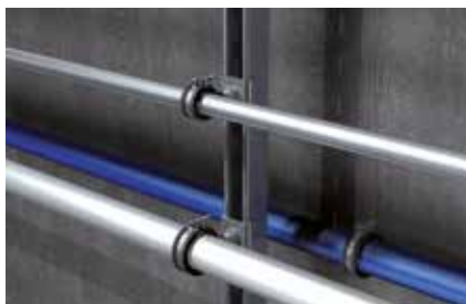
Installazione laterale tubazioni su binario di montaggio
